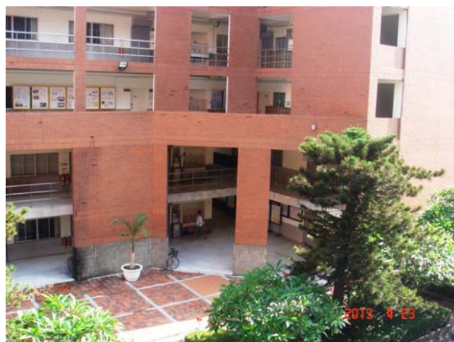
右側的三角形空間破壞大樓原本的稜角，同時也為系辦公室提供遮風避雨的效果。
