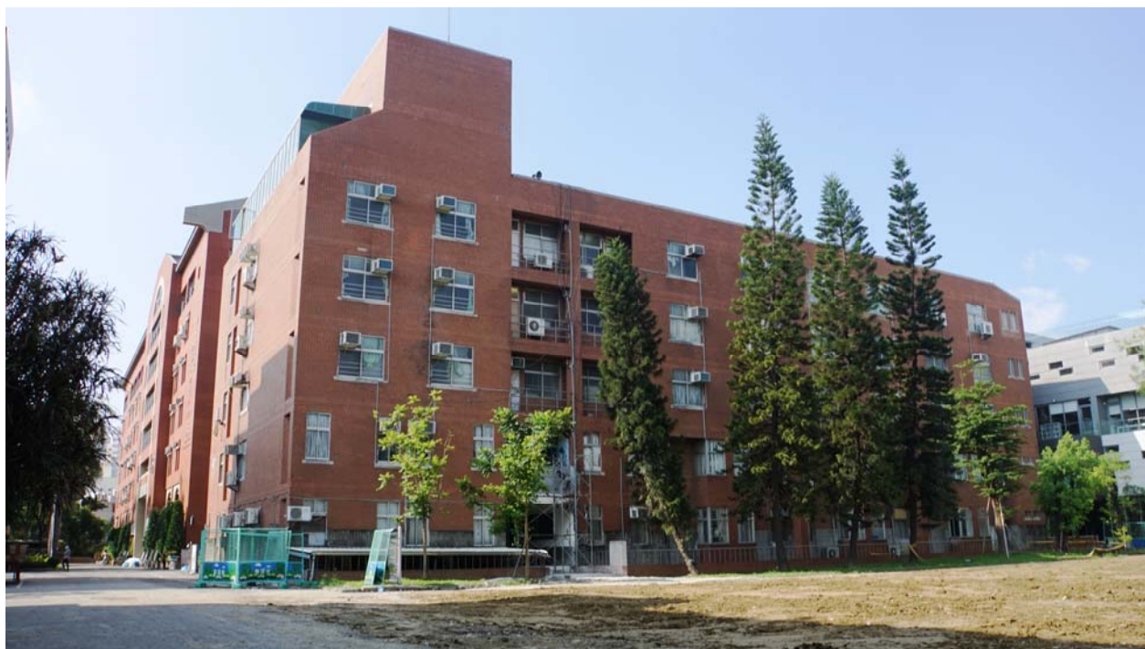
I棟拆除後的J棟景觀
