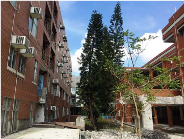
8/16 日，連接 I、J 棟的天橋被拆除
