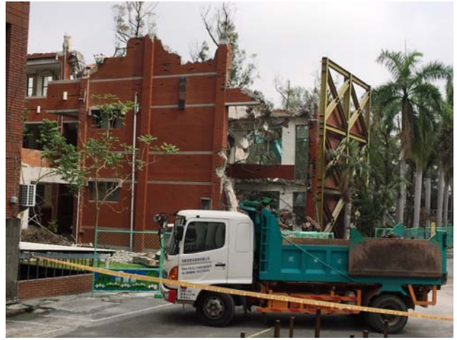
8/20 日，I 棟被怪手拆除
