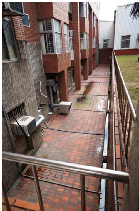
J棟地下一樓設計了約3米的開放空間，讓空氣及光線可以進入地下1樓，獲得良好的採光與通風效果。
