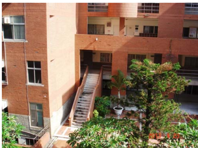
大樓左側的樓梯除具備實用性外，也破壞單調的外型，產生趣味的視覺變化。
